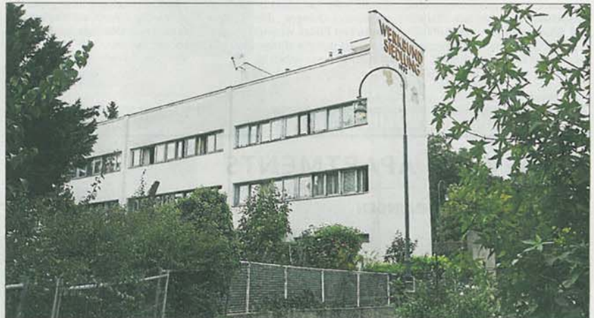
Unter Denkmalschutz und mitten in der Sanierung: die Werkbundsiedlung.
