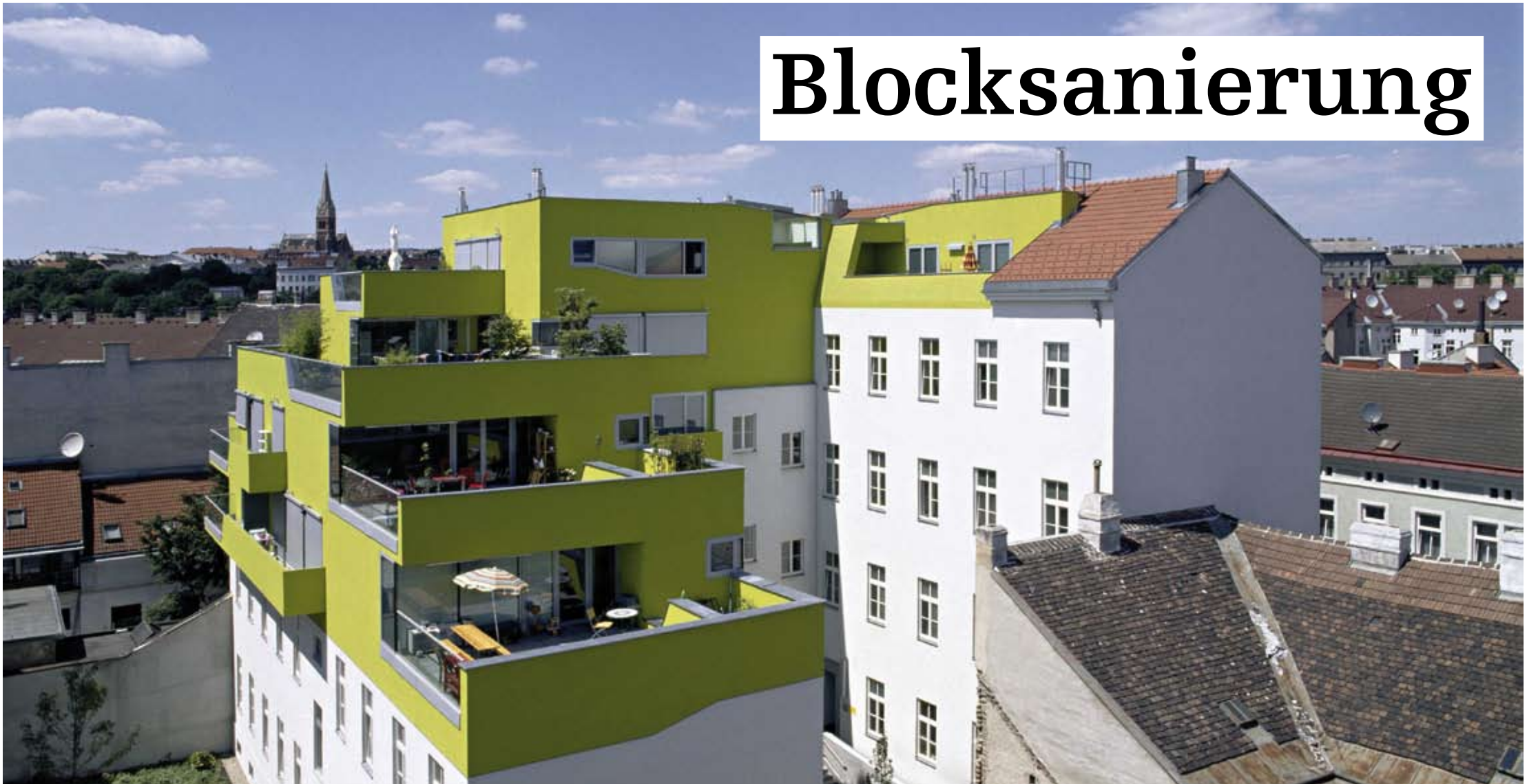
Sanierung des Hinterhoftrakts Sperrgasse 17, in Wien 15, durch das Architekturbüro sigs. Foto: Herta Hurnaus
