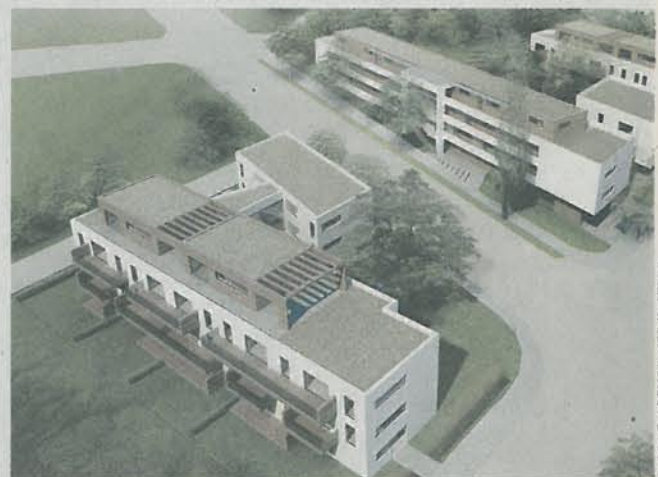
Wohnbau aus Holz an der Breitenfurter Straße von Praschl-Goodarzi
