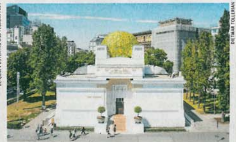
Das gesamte äußere Erscheinungsbild der Wiener Secession wurde mit Liebe zum Detail saniert
