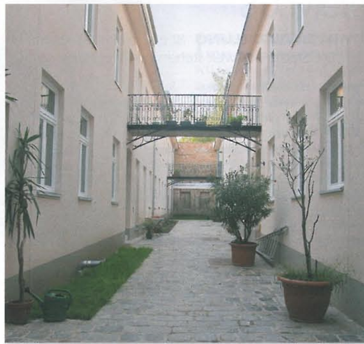
In den Seitenflügeln des siegreichen Sanierungsobjekts Grundsteingasse 32 in Ottakring blieb das markante Erschließungssystem über die Brücken erhalten. PUBA / Sonja Stepanek
