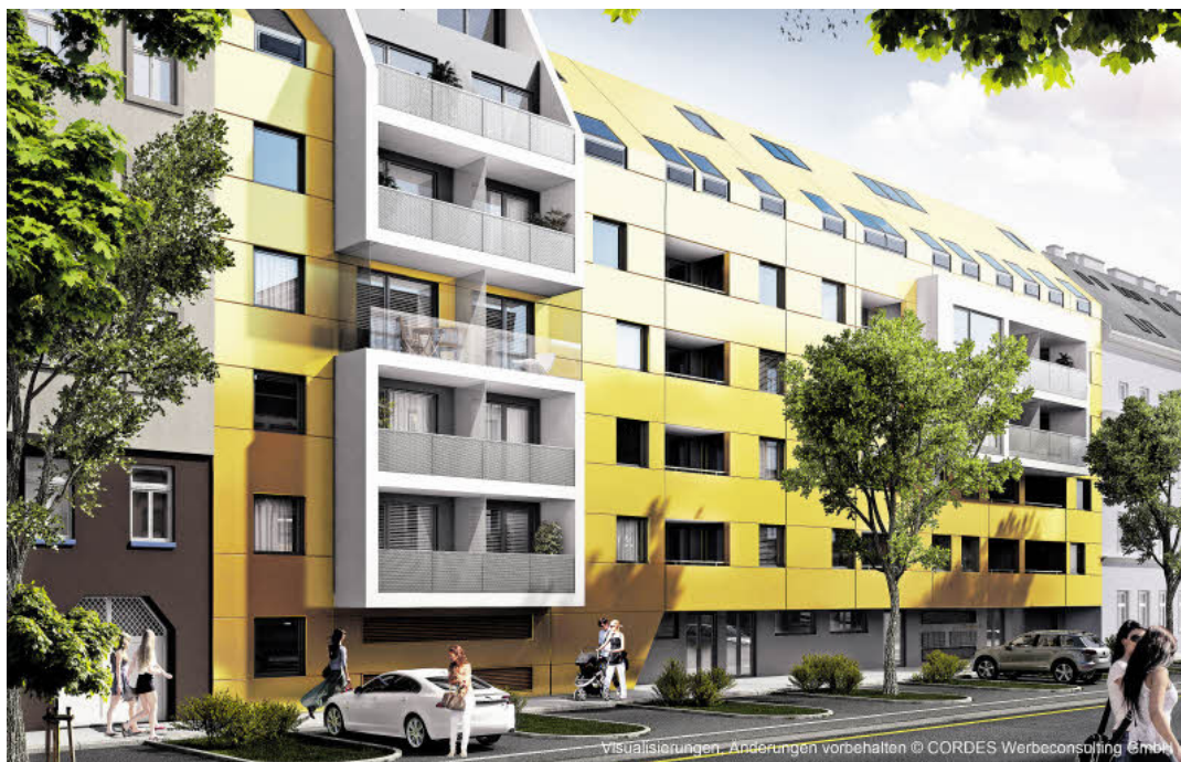
Vorsorgewohnungen vom Feinsten: Schon zur Spatenstichfeier im Mai d. J. waren in der Petrusgasse die meisten Einheiten „fix gebucht“
