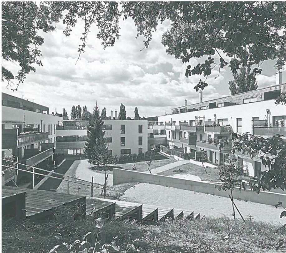
Die Wohnhausanlage Breitenfurter Straße ist bis auf den Sockel ein reiner Holzbau.
